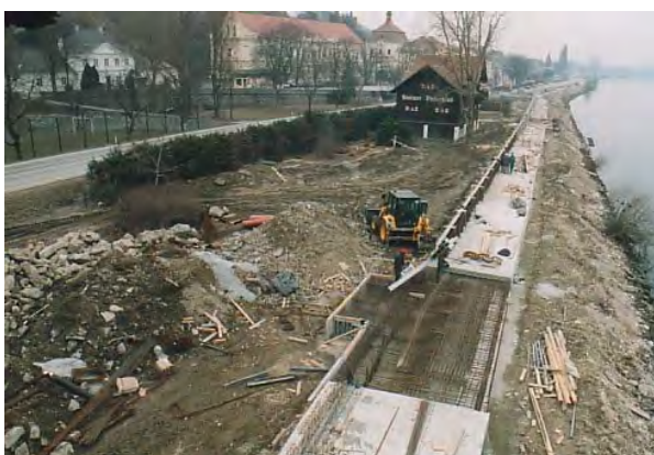
Die Bauarbeiten sind voll in Gang
