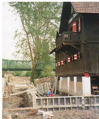
Das Fundamet für den Fitnessraum
